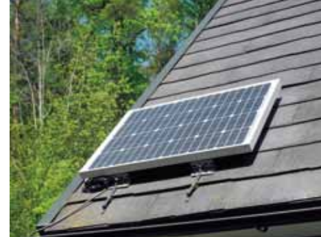
50Wソーラーパネル南面屋根に設置
