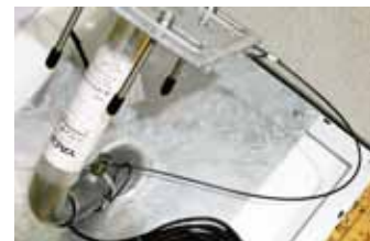
落下防止ワイヤー取り付け
